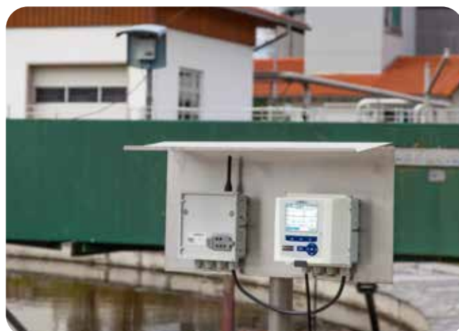
Ideale Schlammspiegelmessung mit System 282/284 und Funkübertragung
