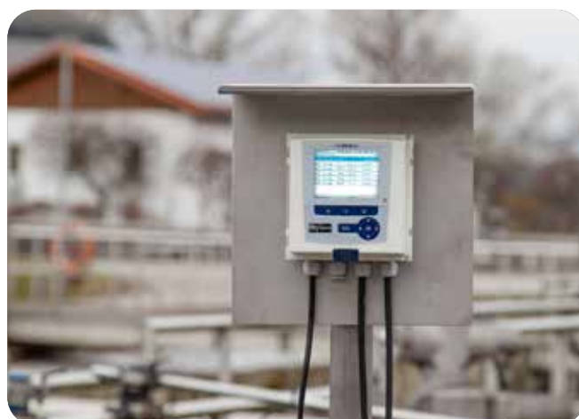
System 282/284 zur Optimierung der biologischen Reinigungsstufe
